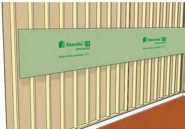
1. Asenna ilmansulkukaista välipohjan kohdalle ukoseinärunkoon ympäri talon.
